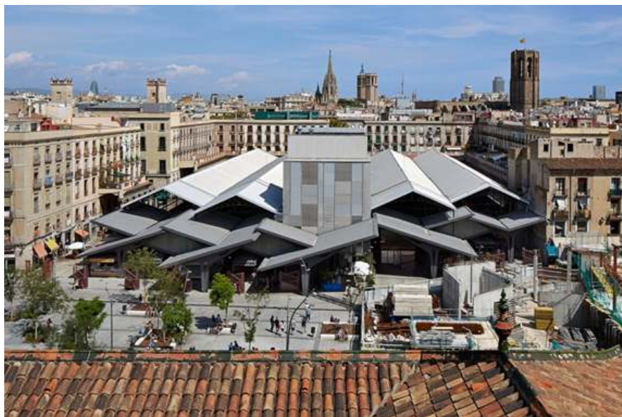
Imagen VI. Fachada Posterior del Mercado de la Boquería en la actualidad - Arquitectura Catalana.
