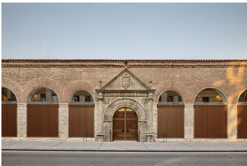
Imagen IV. Restauración de las Reales Carnicerías (RRCC) de Medina del Campo. Valladolid.- Juan Carlos Arnuncio.
